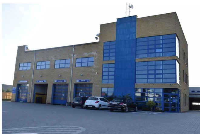
Fot. 7. Budynek stacji kontroli pojazdów w Ćmiłowie
