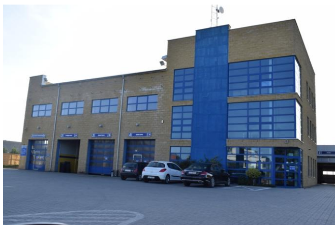
Fot. 7. Budynek stacji kontroli pojazdów w Ćmiłowie
