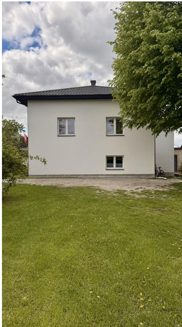
Zmodernizowany dom jednorodzinny w Prawiednikach
