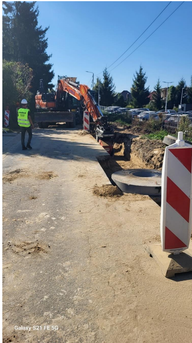
Budowa kanalizacji na ul. Lipowej w Kalinówce
