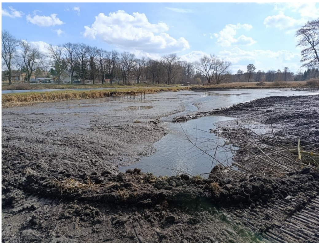
Przebudowa stawu na zbiornik retencyjny
